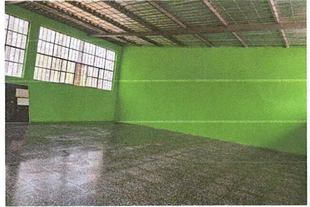
Foto 2: Mejoramiento y sustitución de piso.
