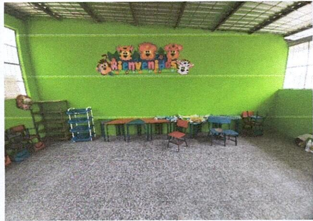
Foto 4: Pintado de paredes
