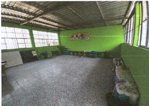
Foto 3: Reparación de repello y cernido de paredes.
