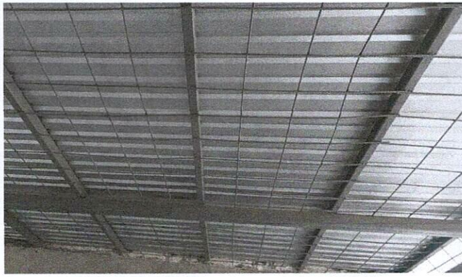
Foto 1: Mejoramiento y sustición de cubierto de lamina.
